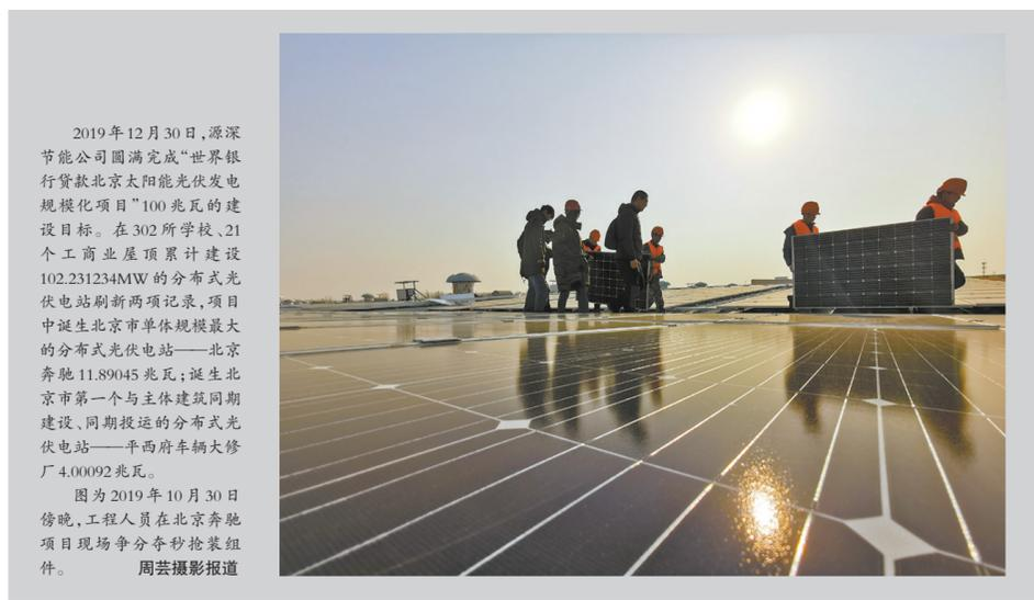
2019年12月30日,源深节能公司圆满完成“世界银行贷款北京太阳能光伏发电规模化项目”100兆瓦的建设目标。在302所学校、21个工商业屋顶累计建设102.231234MW的分布式光伏电站刷新两项记录,项目诞生北京市单体规模最大的分布式光伏电站——北京奔驰11.89045兆瓦;诞生北京市第一个与主体建筑同期建设、同期投运的分布式光伏电站——平西府车辆大修厂4.00092兆瓦。图为2019年10月30日傍晚,工程人员在北京奔驰项目现场争分夺秒抢装组件。周芸摄影报道
